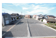
▲楠村町宅地造成
