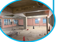
▲内装工事の様子
